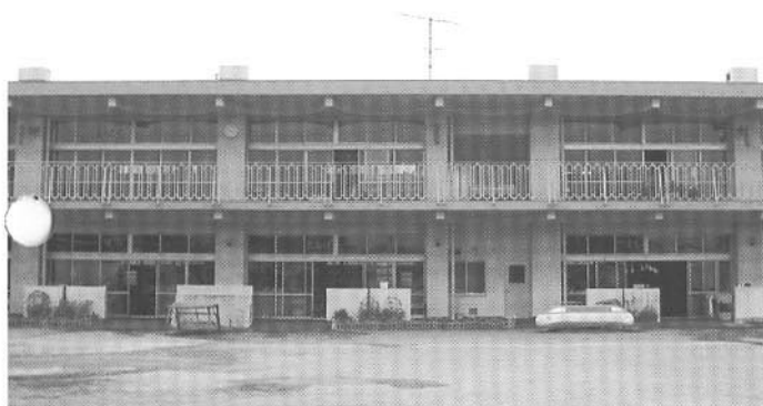
改修の進む春岡幼稚園。規模の大きい幼稚園だが、恒常的な漏水に困っていたという。（写真は改修前）
