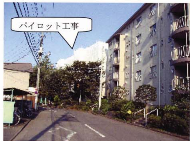
写真—パイロット工事を先行実施
